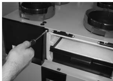
Démonter la trappe d'accès à la carte électronique en enlevant la vis puis en appuyant sur le bouton supérieur.
