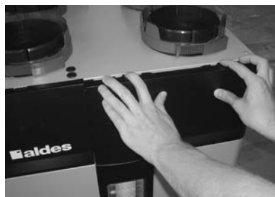
Démonter la trappe d'accès aux filtres de droite en appuyant sur les 2 boutons supérieurs.
