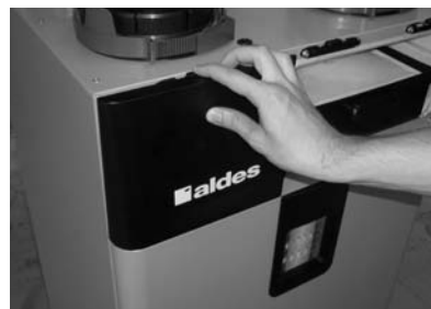
Démonter la trappe d'accès à la carte électronique en enlevant la vis puis en appuyant sur le bouton supérieur.
